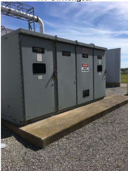
HV Switchgear
