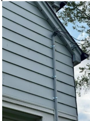
Repaired Overhead Service Conduit
